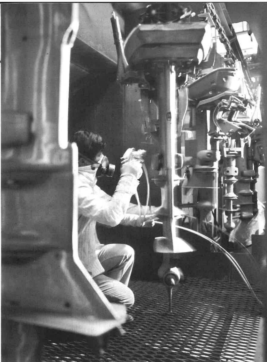
美國舷外機公司的旋轉式內燃機噴上油漆，以防止生鏽。
